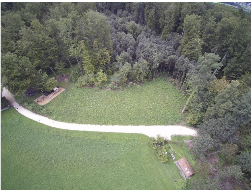
Der Rückbau der Reservoirs Oberholz I und II ist abgeschlossen und die Flächen aufgeforstet und renaturiert.
