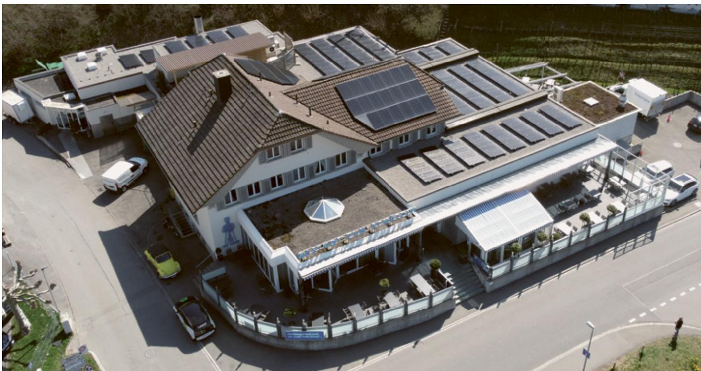
Eniwa hat für den Gasthof zum Schützen in Aarau 183 Solarmodule auf Flach- und Schrägdach in zwei Etappen angebracht. Die Photovoltaikanlage leistet gesamthaft 56,73 kWp und generiert einen Jahresertrag von 51 400 kWh. Die Produktionsmenge entspricht dem Stromverbrauch von ungefähr zwölf Einfamilienhäusern.
