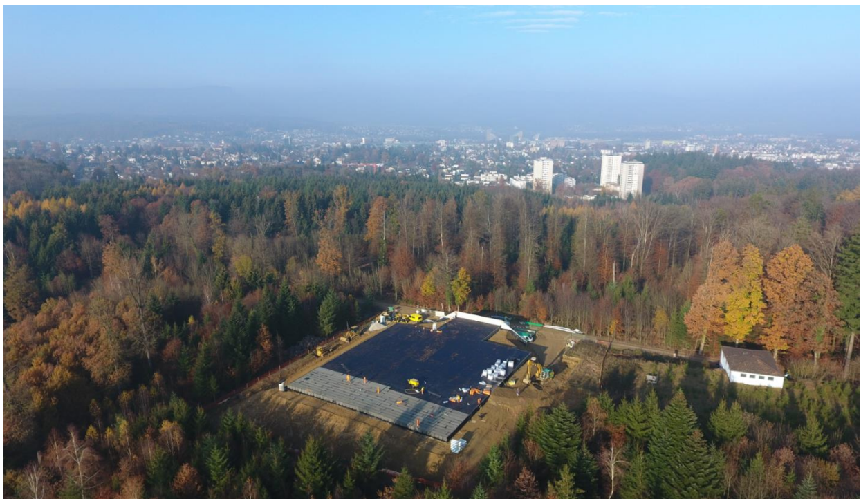
Luftaufnahmen vom neuen Reservoir Gönhard während der Bauphase.
