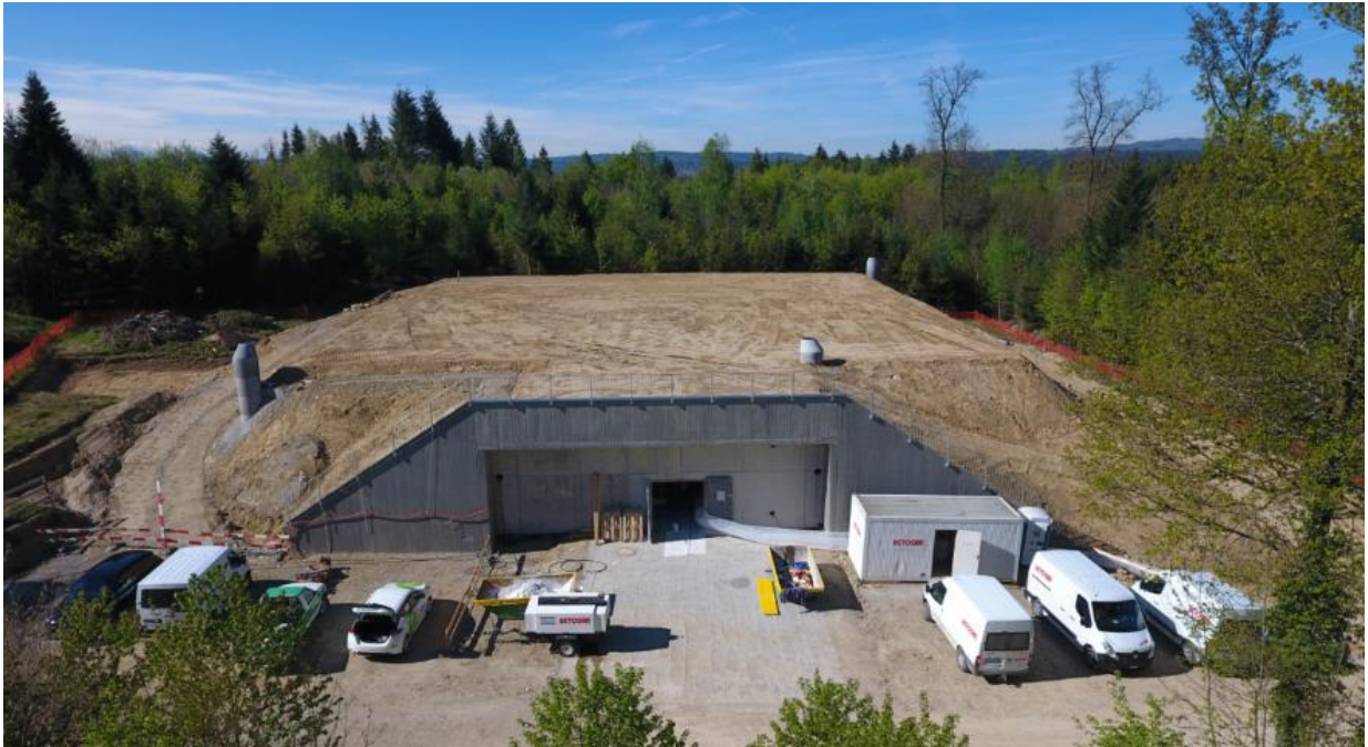
Eingang zum Reservoir Gönhard.
