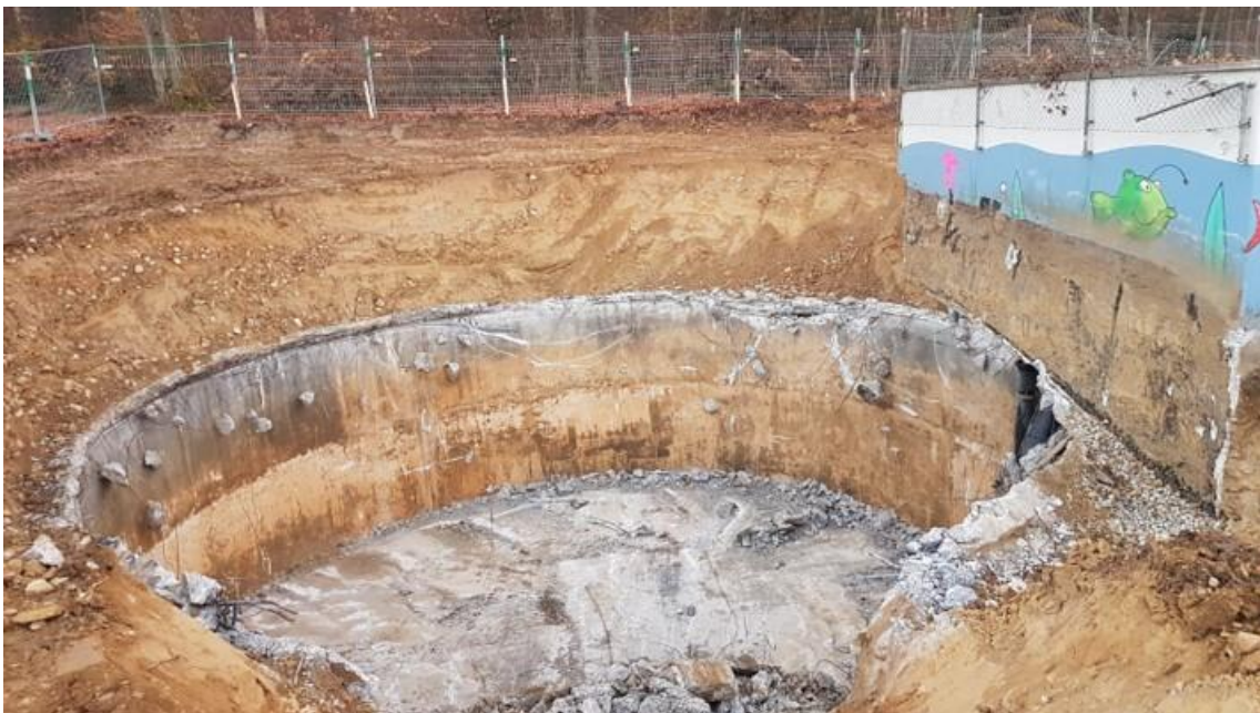
Rückbau der beiden Reservoiranlagen Oberholz I und II.
