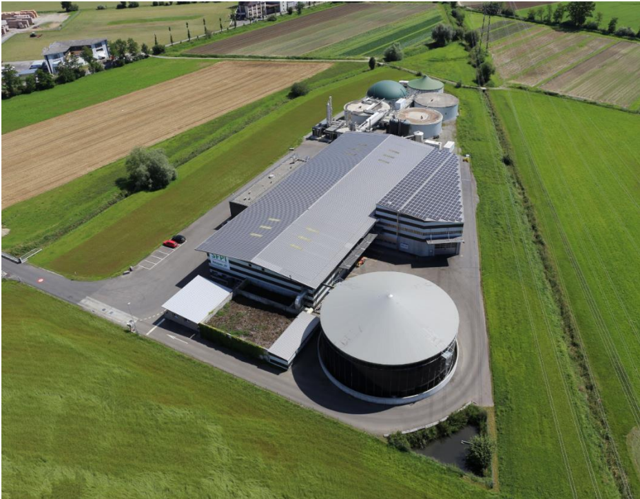
SwissFarmerPower Inwil (SFPI): Eniwa ist an der Biogasanlage im luzernischen Inwil beteiligt. In der Anlage wird aus biogenen Abfällen und Hofdünger Biogas produziert.
