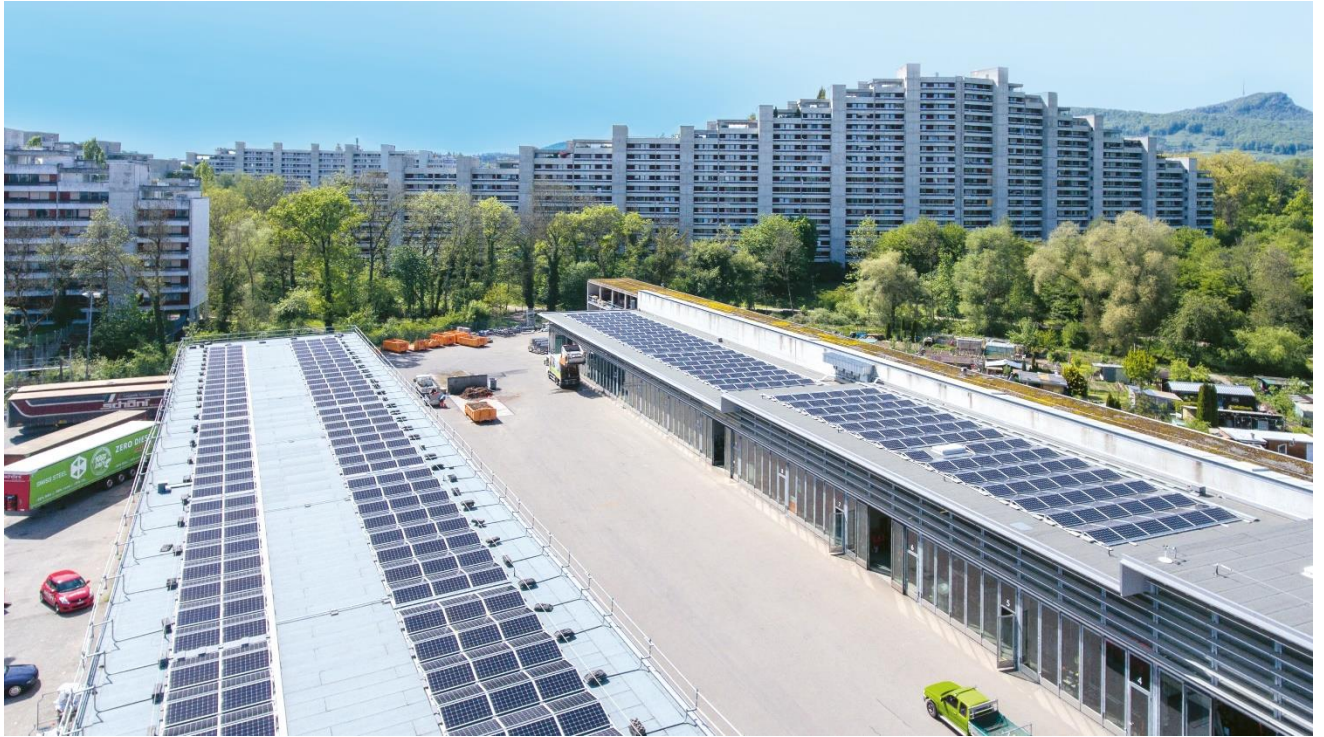
Die beiden gemeinschaftlichen Solarstromanlagen auf dem Dach des Werkhofs der Stadt Aarau.
