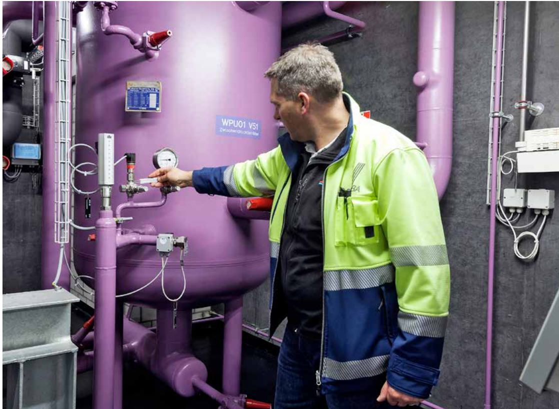
Das Fernwärme-/Fernkältenetz von Eniwa trägt dazu bei, die CO 2 -Belastung zu reduzieren.
