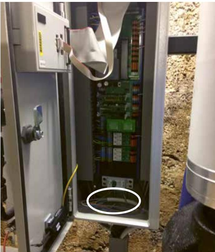
Beispiel vom Standard-Gehäuse mit Regler bei einem einfachem Hausanschluss. Der Reserveplatz unter dem Leitungsschutzschalter ist offen zu lassen.
