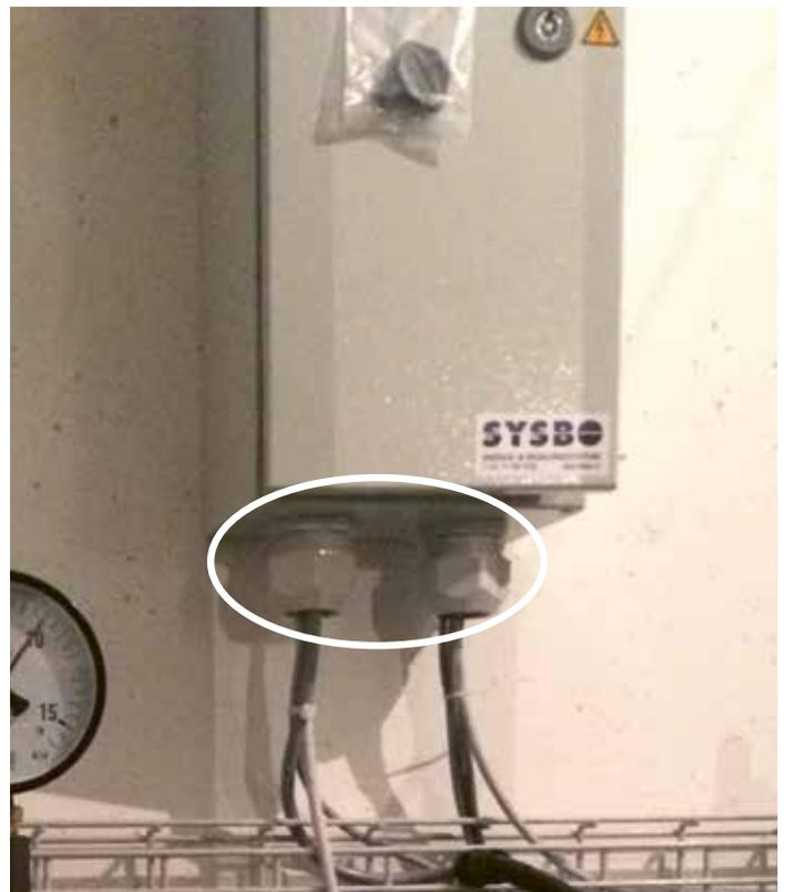
Beispiel einer Kabeleinführung beim Standard-Gehäuse. Platzreserve auf Klemmschiene bei Bedarf! (Erlaubt optimale Platzausnutzung im Gehäuse.)
