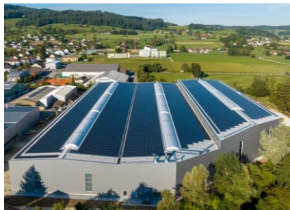
PV Anlage Kaltband AG, 2 MW
