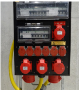
Steckdosenkasten Gifas
